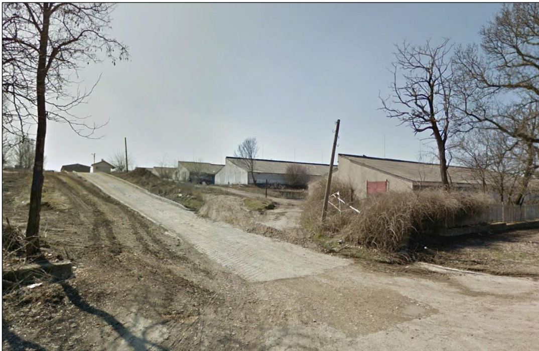
Снимка 5. Изглед към съществуващи постройки в новопредвидената УЗ 1/Смф, с. Телериг, община Крушари
